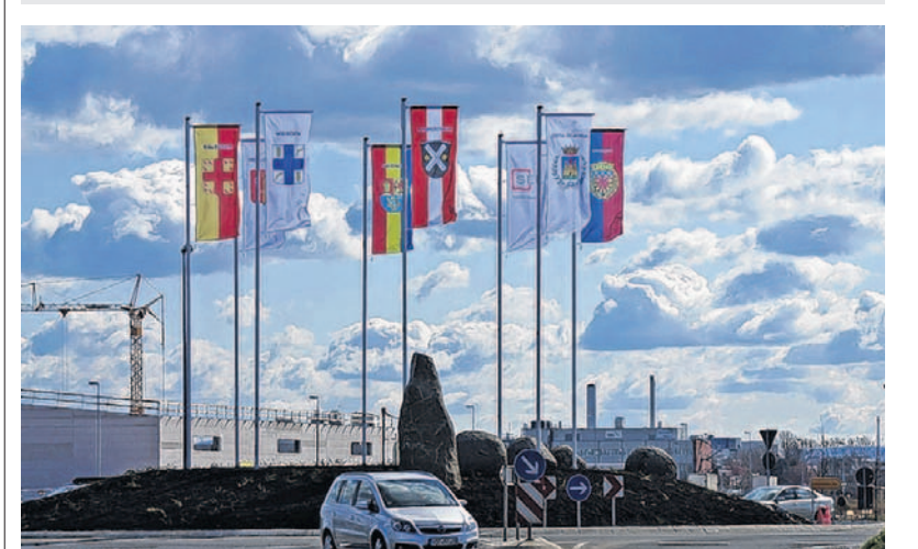
Es geht voran: Der Kreisel vor den Toren des Industrie- und Gewerbegebietes an der Wormser Landstraße.
